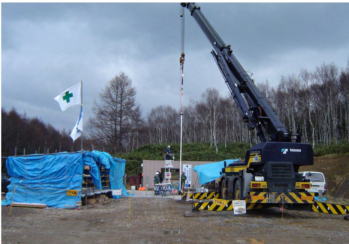
ボーリング調査終了後、機材や櫓を撤去し、ボーリング孔内に地下水圧モニタリング装置を設置
